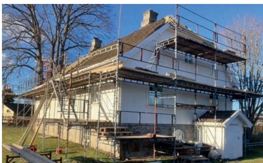
Takreparasjon på hovedhuset på Brår.
