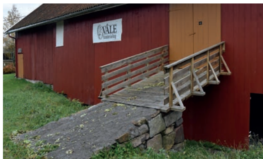
Den nye låvebrua har fått rekkverk...
